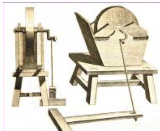
Рисунок из описания точильно-шлифовального станка с кривошипным ножным приводом и емкостью для охлаждающей жидкости. Такие станки служили верой и правдой более тысячи лет
