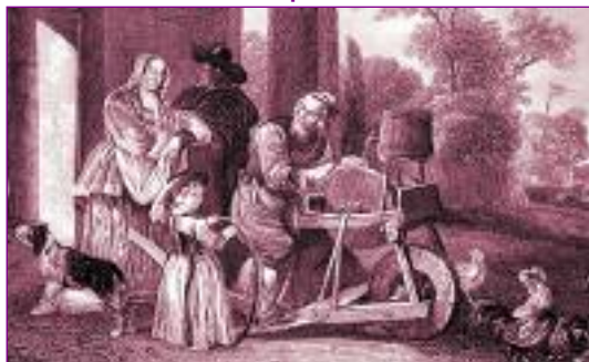
Бродячий шлифовальщик с кривошипным заточным станком с охлаждением и с колесом для перевозки станка. Немецкая гравюра 1853 г.
