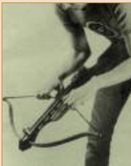
Алгоритм натяжения тетивы, взведения арбалета с помощью рук и выключения предохранителя перед выстрелом
